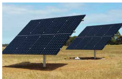
Eje central vertical - autoportante (pequeño grupo de paneles)
